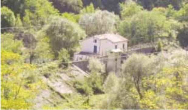
Trattasi di uno sbarramento di ridotte dimensioni che ha dato origine a un bacino artificiale. Lo sbarramento risulta invalicabile per la fauna ittica per cui in una sua possibile utilizzazione deve essere provvisto di una scala di rimonta.
